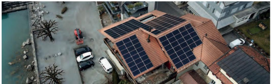
**Module:** 117 Neo Solar Power D6M E3A 305W, **Wechselrichter:** 2 Solaredge SE15k,
