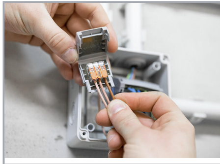
Verdrahtete Klemme in die Gelbox einlegen.
