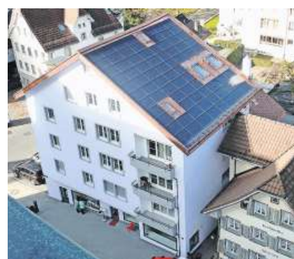
Blick auf die Fotovoltaik-Anlage. Bild: PD
