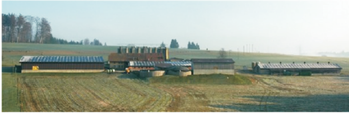
Auf vier Dächern des landwirtschaftlichen Betriebs von Philipp Barmettler sind 1204 Photovoltaik-Module angebracht. Fotos: egu
