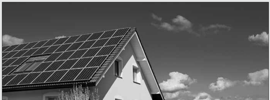
Eine Photovoltaikanlage auf dem eigenen Dach kann auch in der Nacht Strom liefern – mit einem Energiespeicher.
